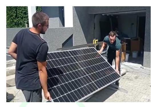
Befestigen Sie das erste Modul mit der Platte ordnungsgemäß mit Endklemmen und Mittelklemmen.
