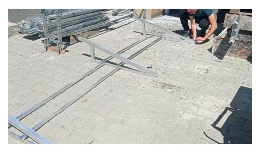
• Befestigen Sie nun die Schellen mit einer Inbusschraube und einer Mutter mit Kunststoffklammer (um 90° gedreht auf dem Easy Roof einsetzen).
